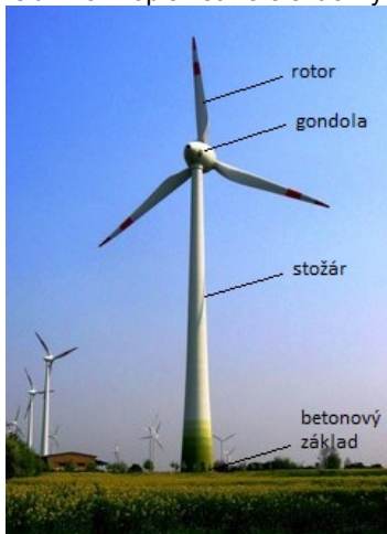
Obr. 43: Popis větrné elektrárny
