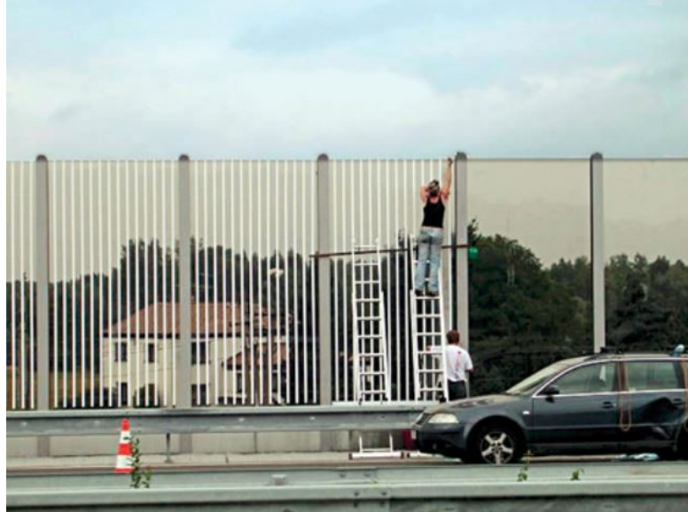
Obr. 22: Instalace lepených pruhů na protihlukovou stěnu na D47 (foto J. Mayer).
