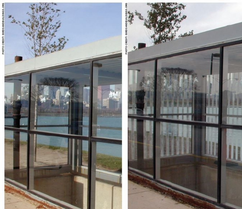
Obr. 21: Prosklený vchod byl opatřen svislým pruhováním na stěnách přiléhajících k jezeru (foto: Bird safe guidelines, New York City Audubon Society 2007)
