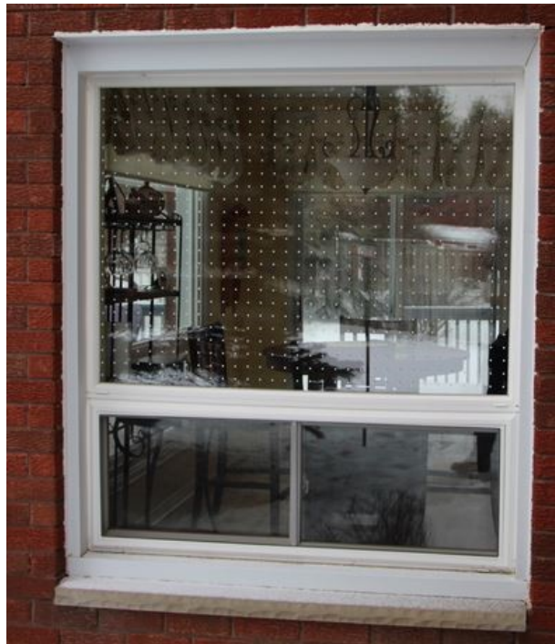
Obr. 24: Ukázka upraveného povrchu okna za pomoci teček.
