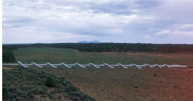
Obr. 4: Obrázek znázorňuje plastový spirální tlumič vibrací.
