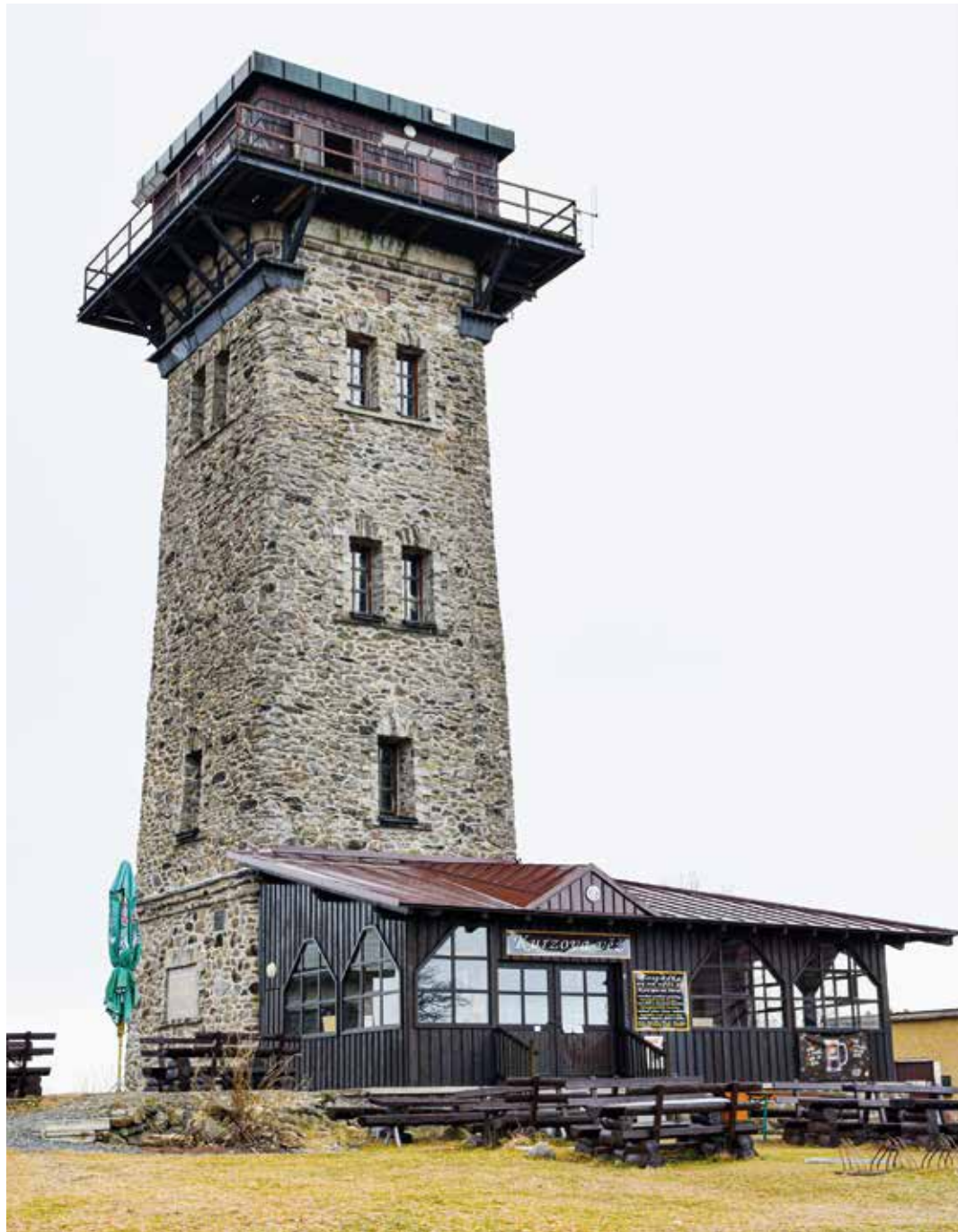
Kurzova věž a zázemí pro turisty obnovené v roce 2016 v místě bývalé Pasovského chýše, rok 2021, foto M. Jiran.
