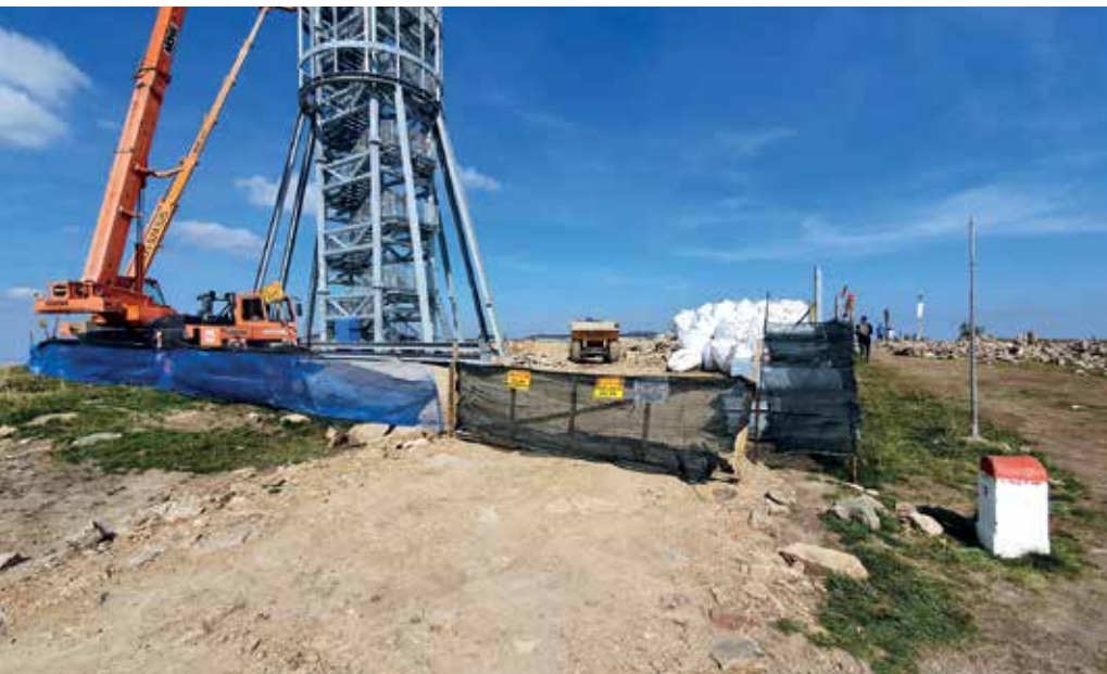
Rozestavěný objekt rozhledny na vrcholu. Autor: Marek Banaš
