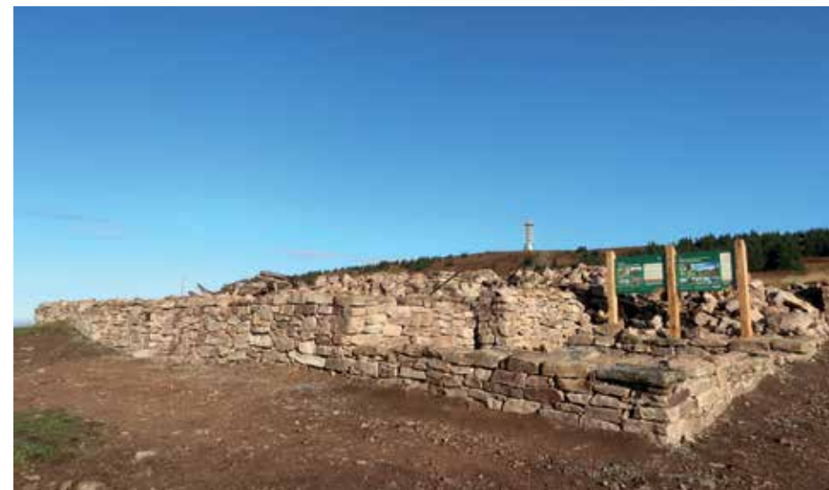
Na místě bývalé Liechtensteinovy chaty byly po provedených sanačních pracích v roce 2021 zachovány základy původního objektu. Nově byly doplněny informační panely. Autor: Miroslav Havira
